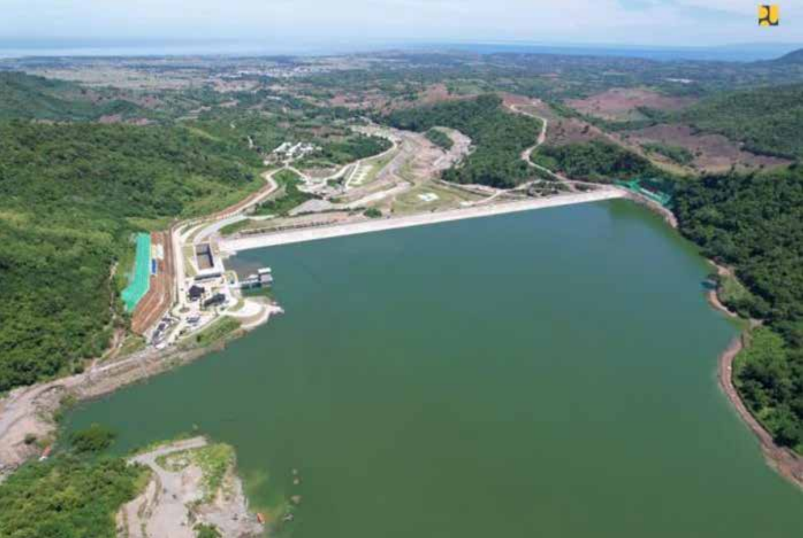
Gambar 48. Bendungan Bener dengan Tipe Urugan, di Desa Guntur, Kecamatan Bener, Kabupaten Purworejo, Jawa Tengah.
