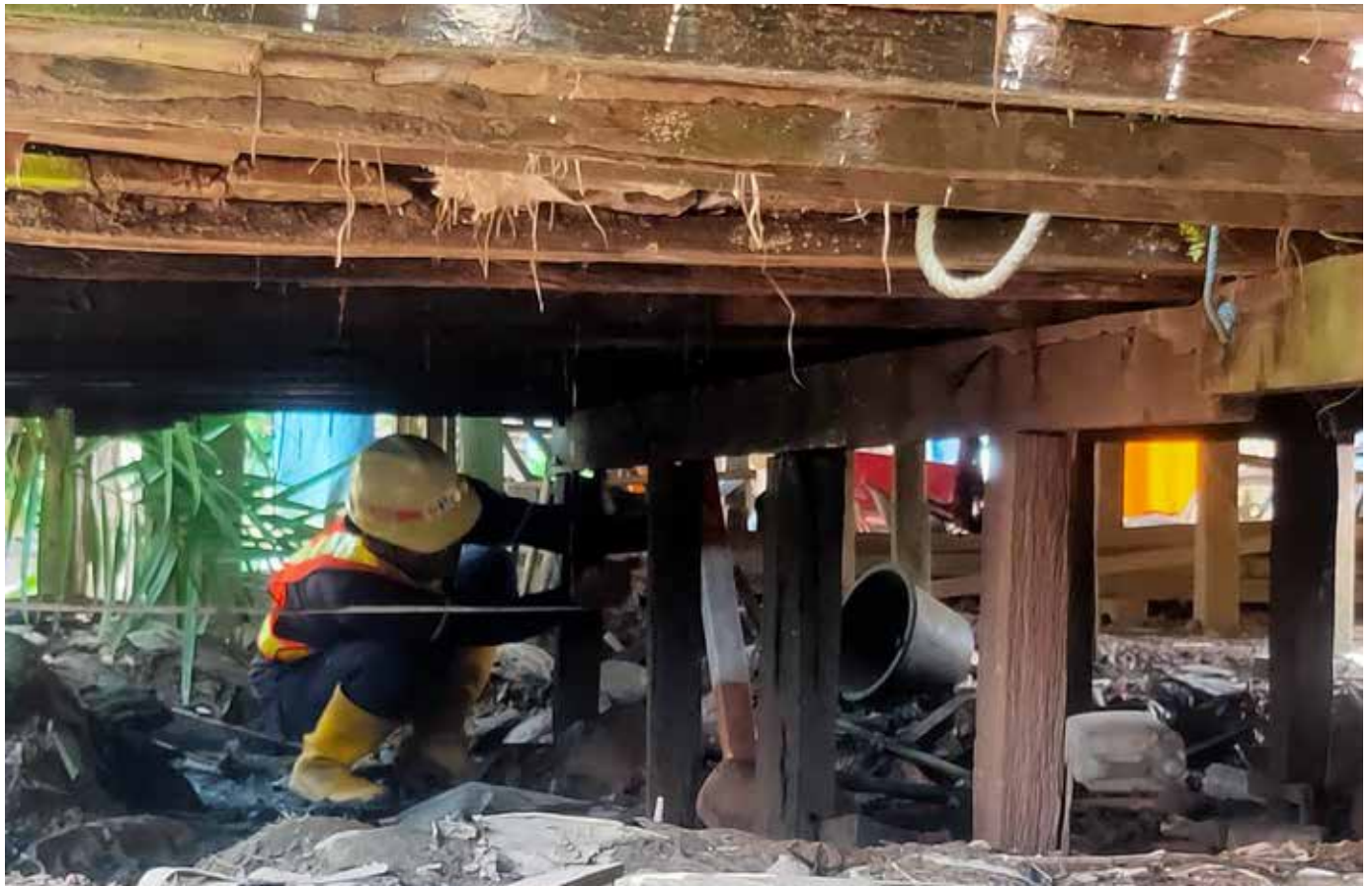
Gambar 50. Pemasangan patok di bawah kolong rumah masyarakat.
