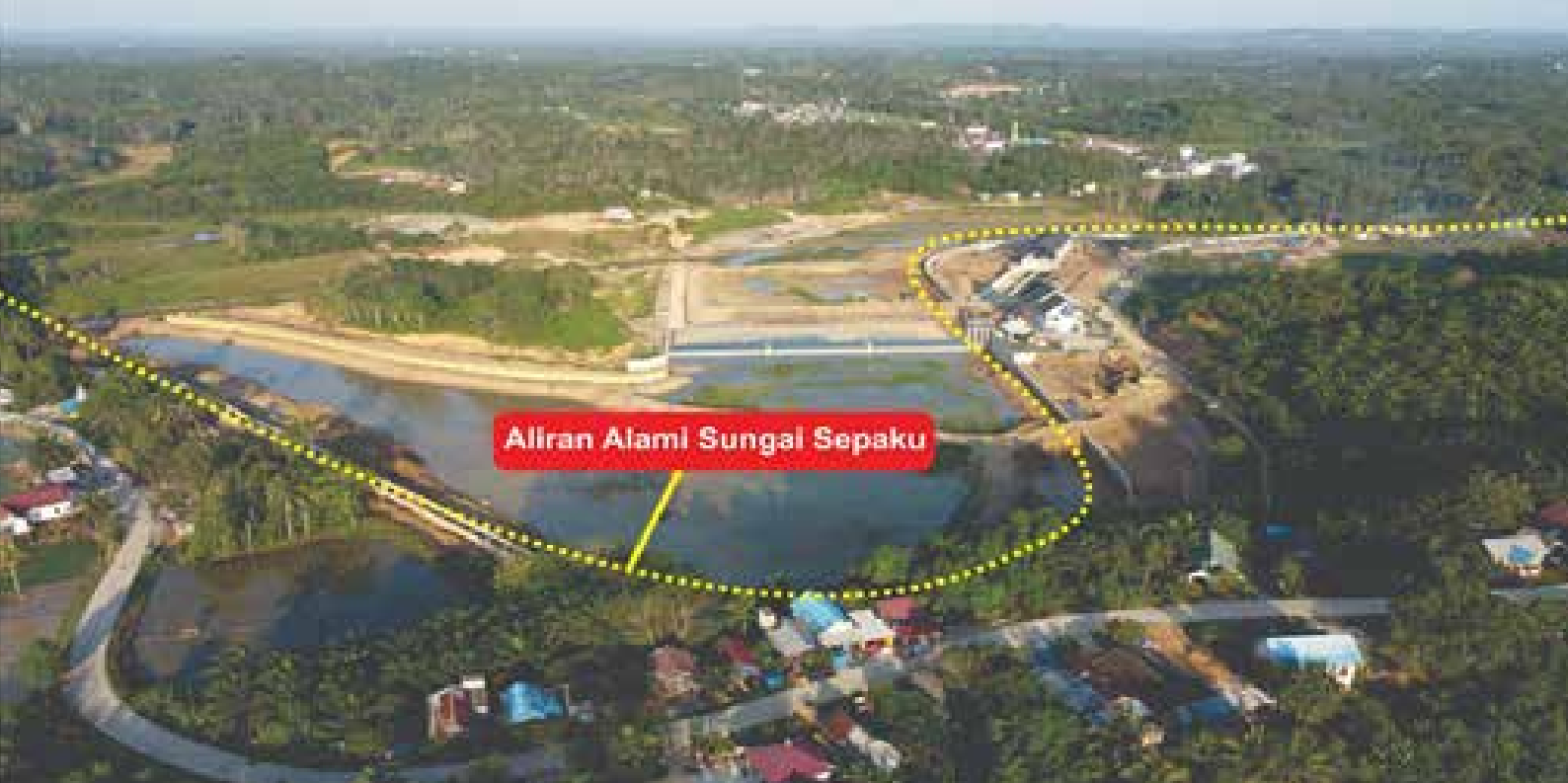
Gambar 35. Lokasi Proyek Intake yang memotong Sungai Sepaku, di Kelurahan Sepaku.
