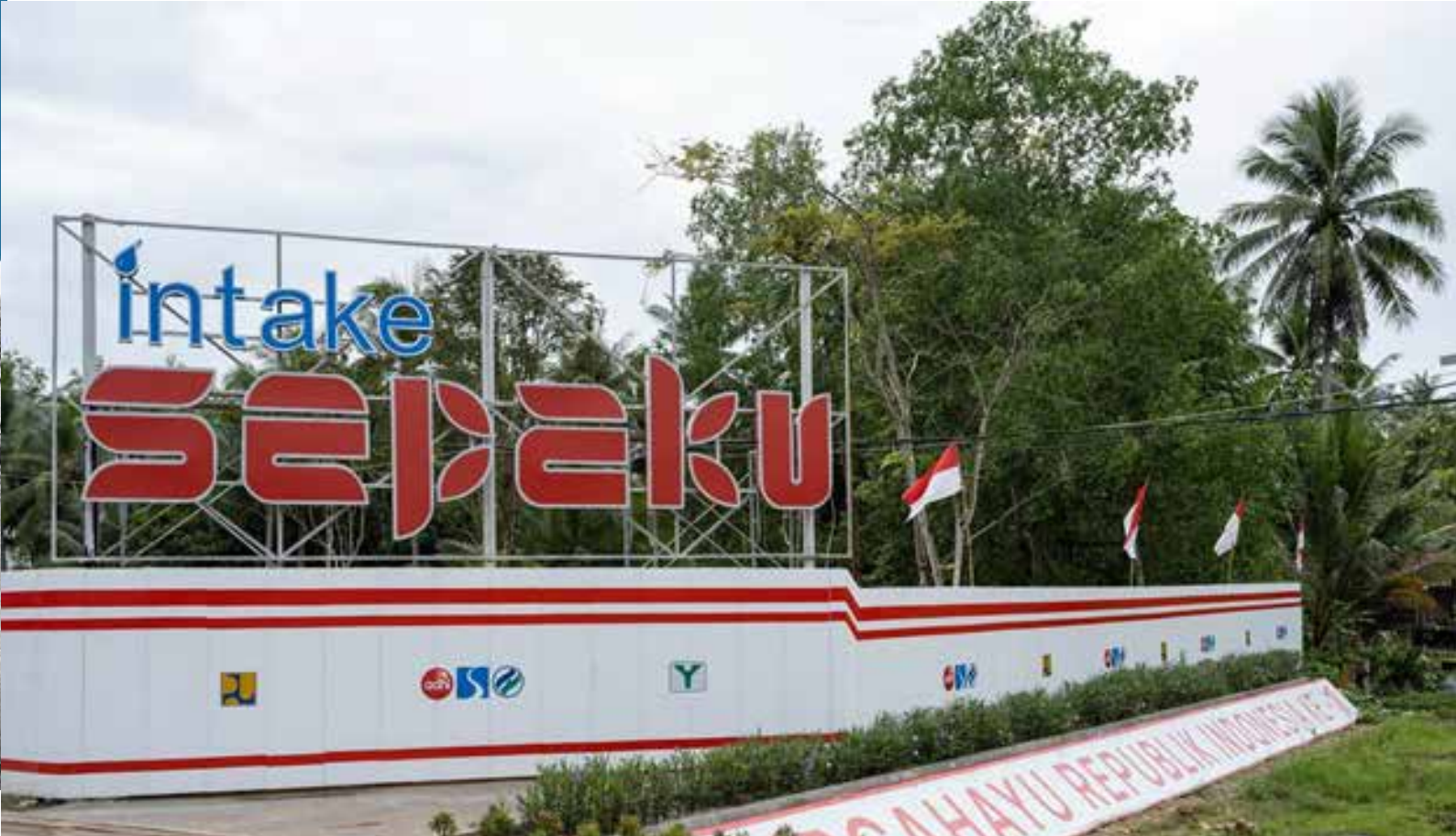
Gambar 23. Proyek Intake Sungai Sepaku di Kelurahan Sepaku.
